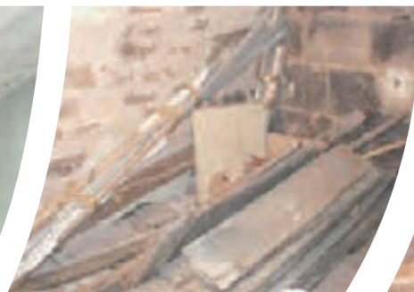
Exemple d'encombrement dans une cave
