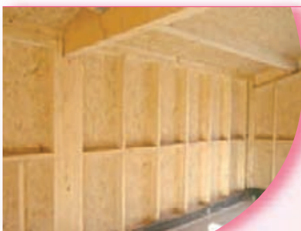
Murs à ossature bois
